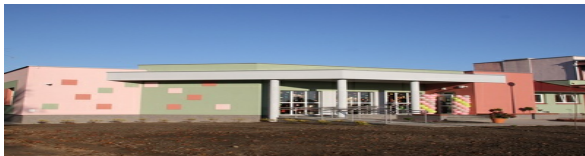
Budowa Przedszkola w Starych Oborzyskach
