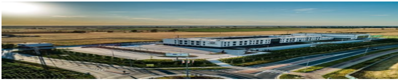
Budowa Zespołu Szkół Technicznych w Tarnowie Podgórnym
