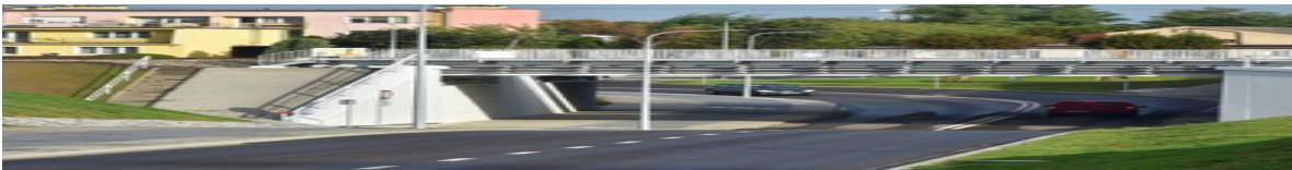
Rozbudowa układu drogowego ul. Pod Trzema Mostami w Gnieźnie, na odcinku od al. Reymonta do ul. Osiniec.
