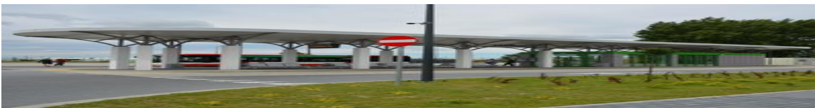
Budowa zintegrowanego węzła przesiadkowego wraz z infrastrukturą towarzyszącą oraz inwestycje w zakresie publicznego transportu zbiorowego na terenie Gminy Kleszczewo.
