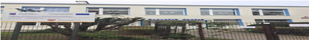
Poprawa efektywności energetycznej budynków użyteczności publicznej Ostrowa Wielkopolskiego
