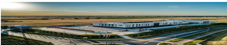
Budowa Zespołu Szkół Technicznych w Tarnowie Podgórny
