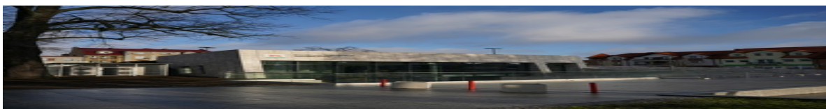
Zagospodarowanie Placu Pocztowego wraz z utworzeniem Centrum Integracji Społecznej oraz zagospodarowanie terenu Targowiska Miejskiego wraz z terenami przyległymi.
