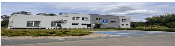
Budowa domu dziennego pobytu w Wolsztynie
