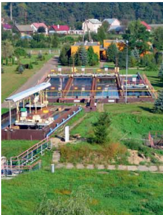
Oczyszczalnia ścieków w Treczy (fot. Edyta Drwiega)
