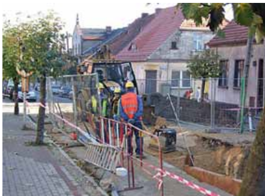
Budowa kanalizacji w Śmigłu (fot. Agnieszka Purczyńska)
