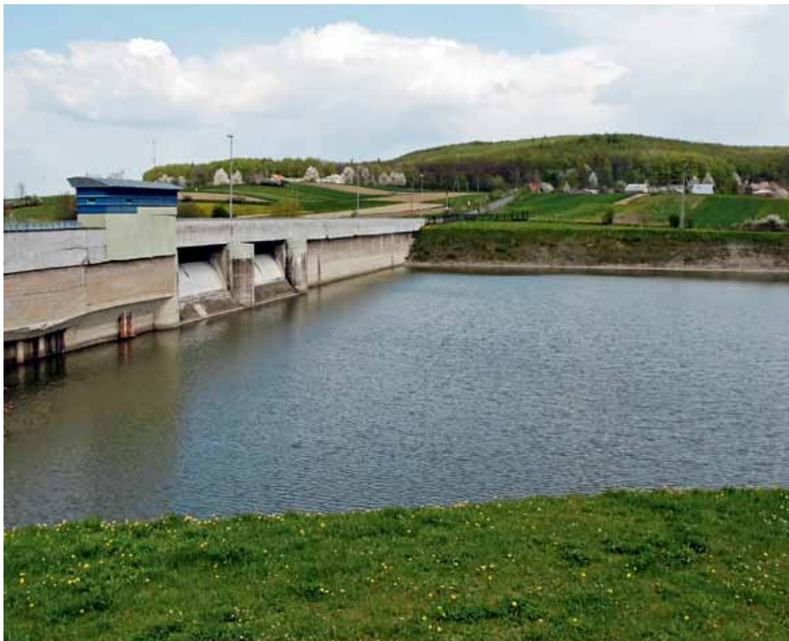
Zakład Uzdatniania Wody w Sieniawie wraz z zaporą (fot. Ariusz Nawrocki)
