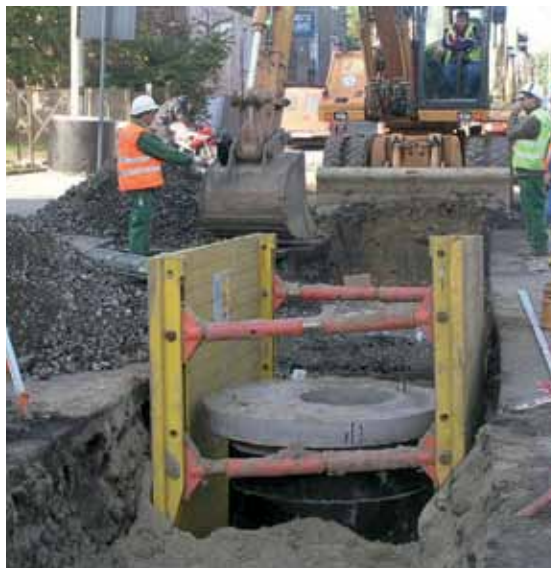
Roboty kanalizacyjne w ul. Dolnej Wsi (fot. PWiK Gliwice)
