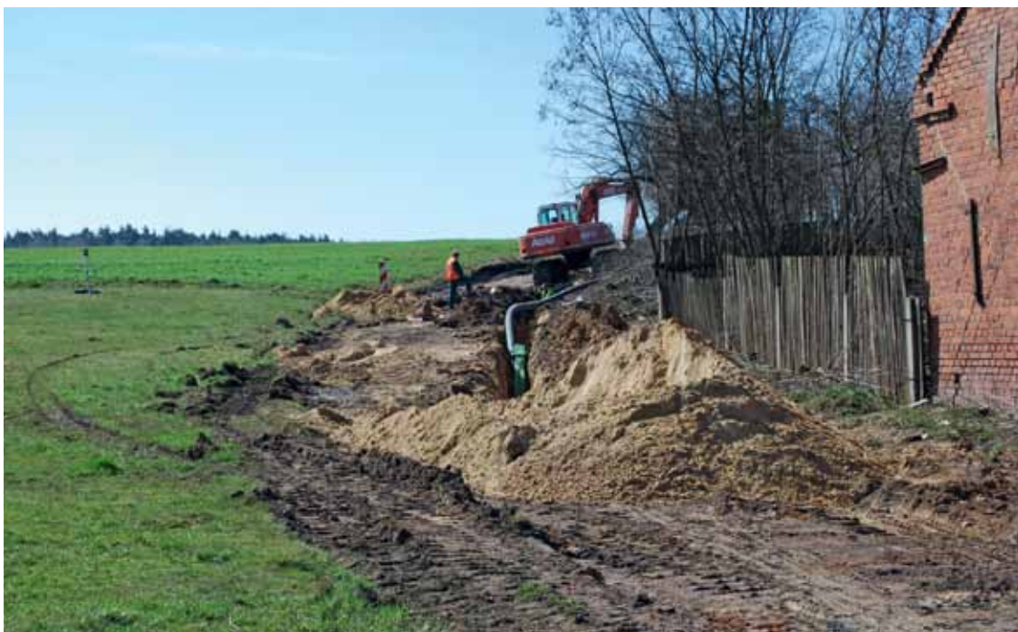
Budowa kanalizacji w Bruszczewie (fot. Agnieszka Purczyńska)
