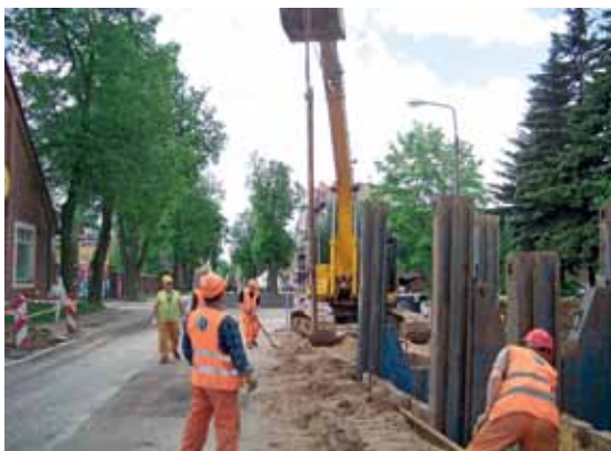
Budowa kanału deszczowego (fot. archiwum PWIK Elk)
