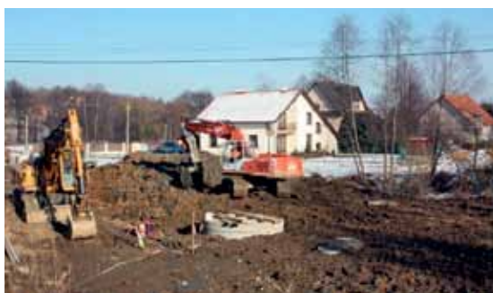
Fragment rurociągu tłocznego w miejscowości Krzyszkowice (fot. archiwum JRP)
