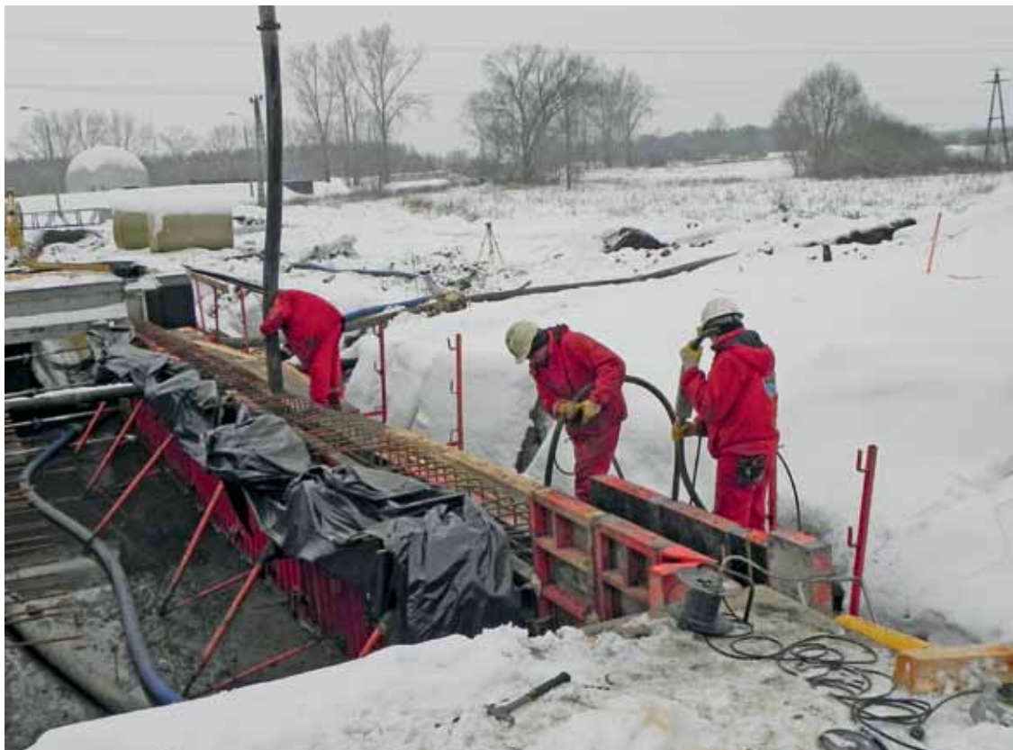
Budowa kolektorów zastępujących rów Strzala (fot. Archiwum PWiK)
