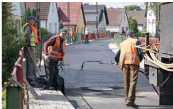
Roboty ziemne w Goleniowie – Kontrakt III (fot. K. Bitenc)
