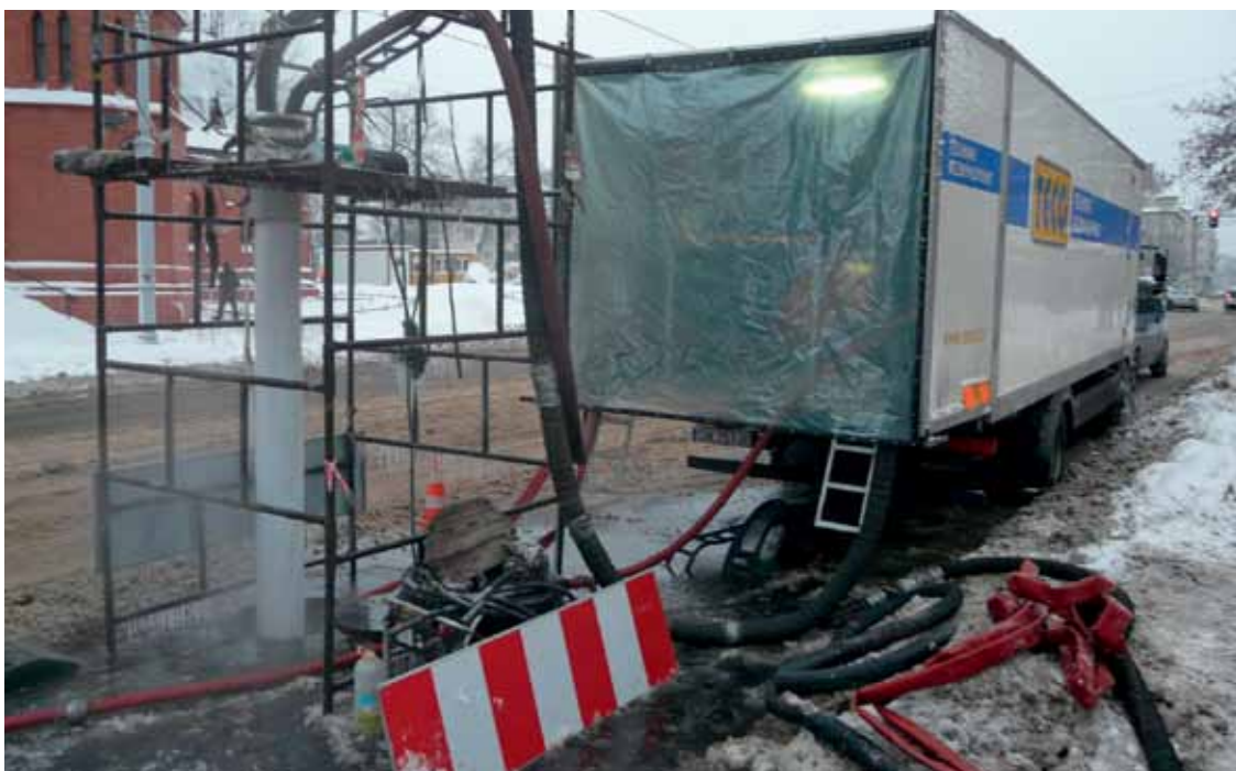
Renowacja kanalizacji sanitarnej – Toruń, ul. Szpitalna Kontrakt K-6/WV pn. „Renowacja sieci kanalizacyjnej na terenie miasta Torunia w technologii bezwykopowej” (fot. Piotr Rabant)
