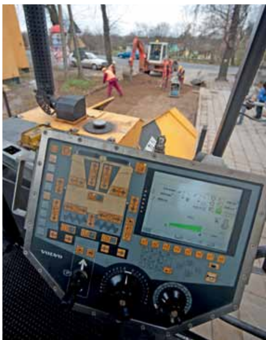
Kontrakt 1B – Budowa kanalizacji w dzielnicy Centrum
