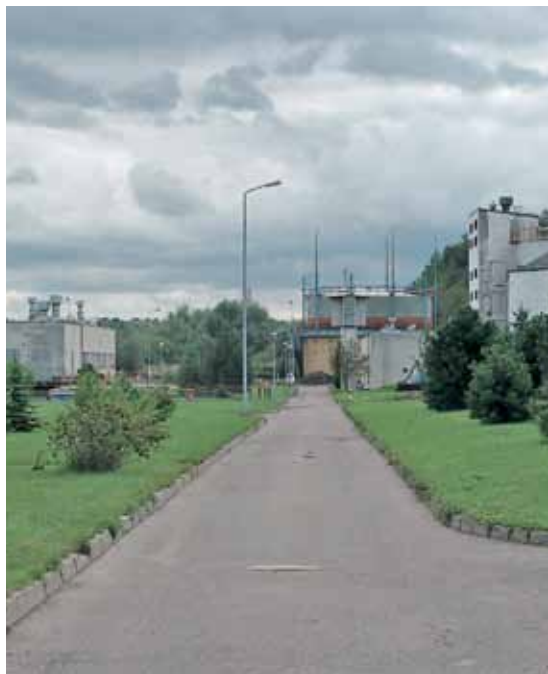
Oczyszczalnia ścieków w Treczy (fot. Edyta Drwiega)
