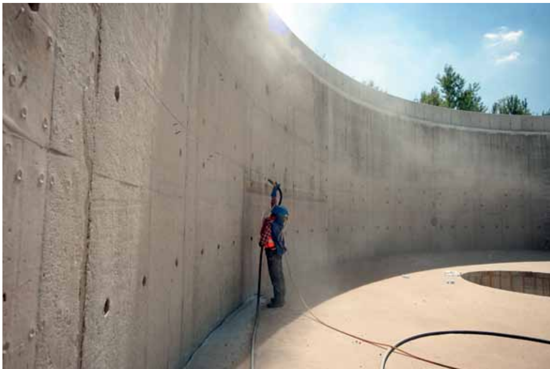
Kontrakt 2 – Budowa Centralnej Oczyszczalni Ścieków (piaskowanie zbiornika)
