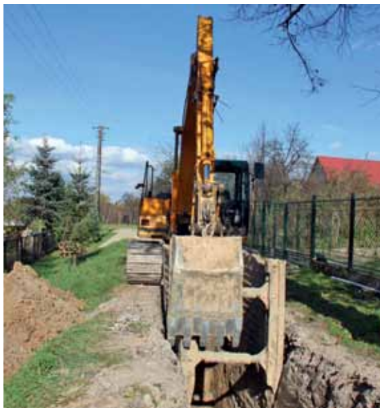
Prace budowlane. Zadanie I
