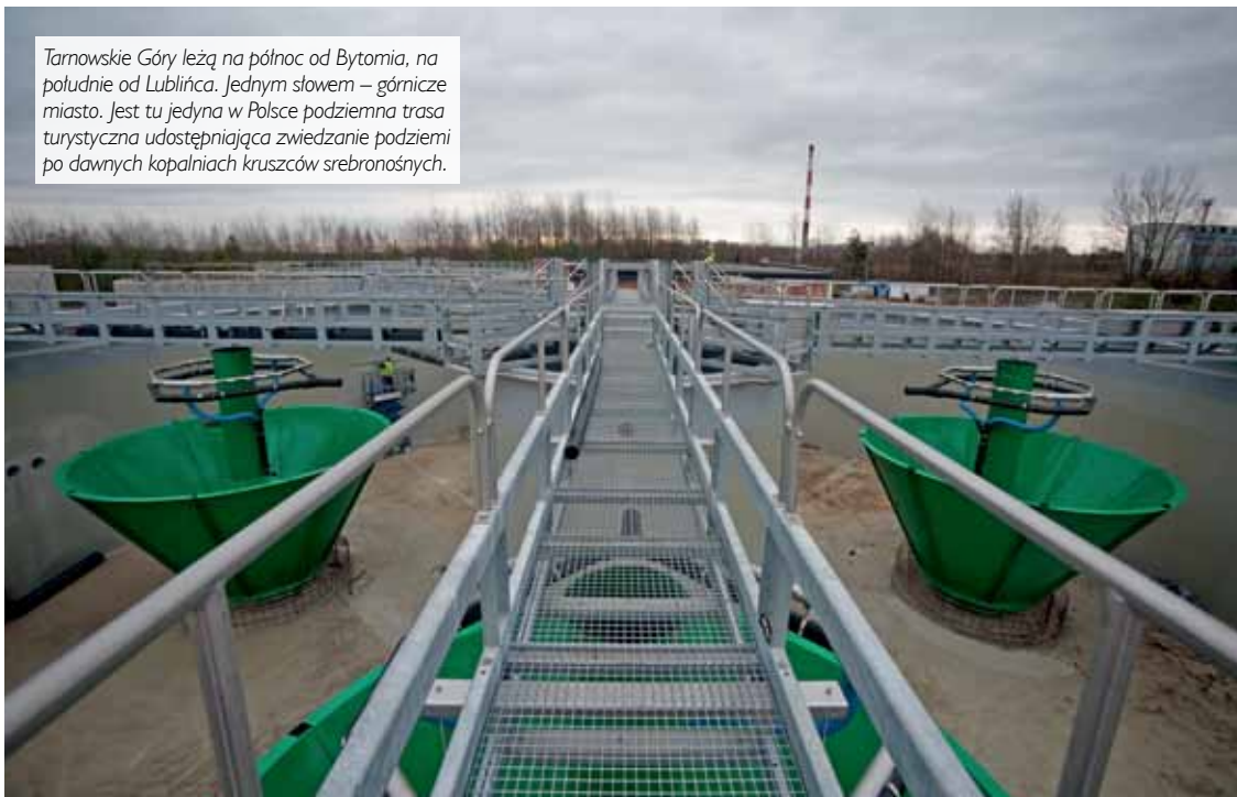
Kontrakt 2 – Budowa Centralnej Oczyszczalni Ścieków (reaktor biologiczny)
