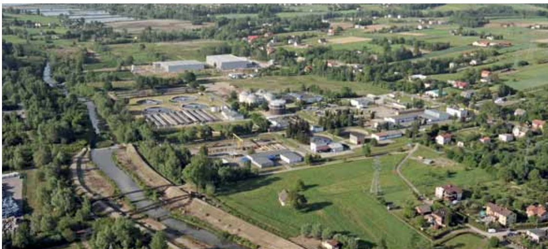
Oczyszczalnia ścieków w Komorowicach (fot. Archiwum „AQUA” S.A.)
