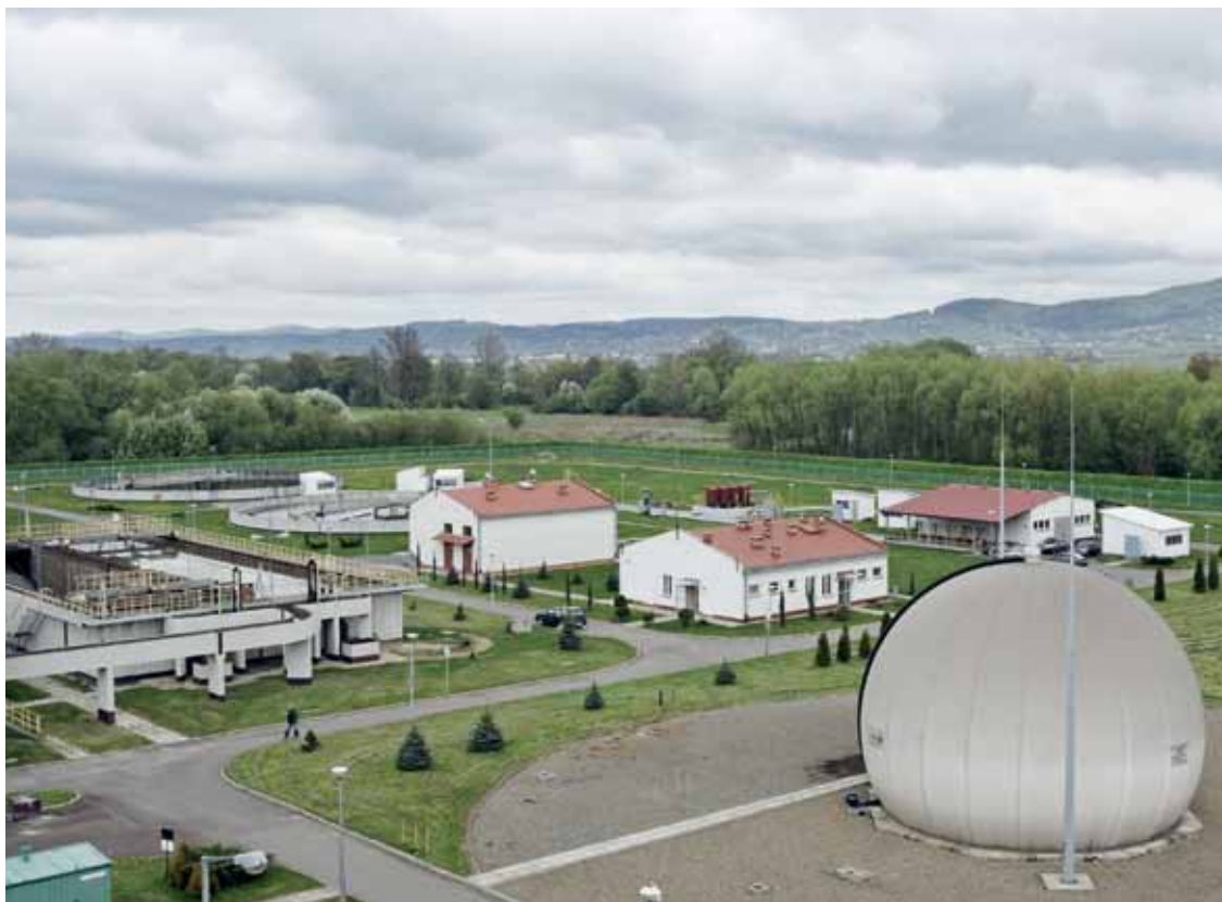
Oczyszczalnia ścieków w Krośnie (fot. Ariusz Nawrocki)
