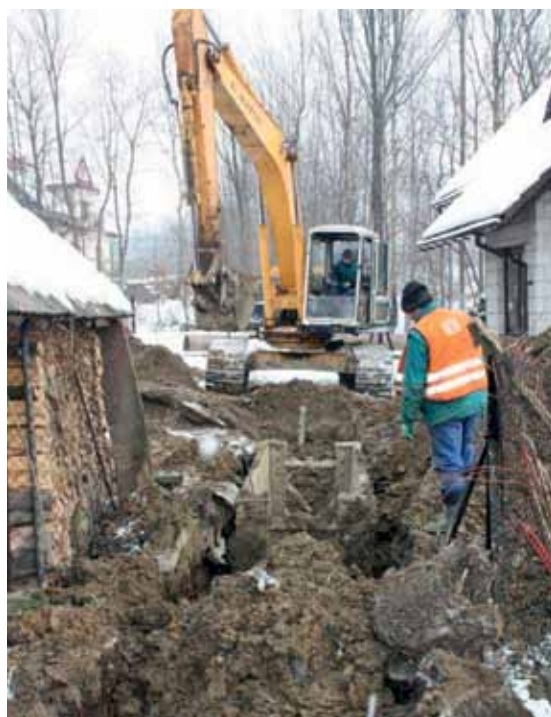
Budowa kanalizacji sanitarnej w miejscowości Jasienica (fot. archiwum JRP)
