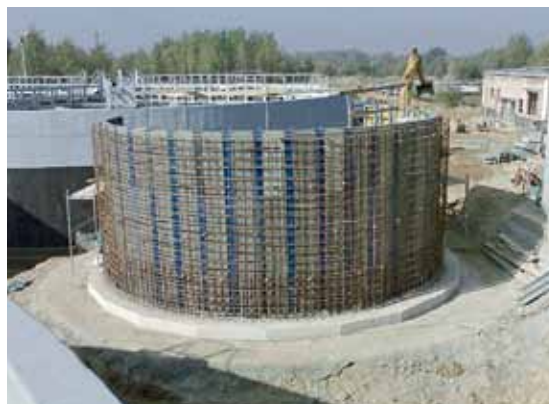
Kontrakt 2 – Budowa Centralnej Oczyszczalni Ścieków (zagęszczacz osadu wstępnego)
