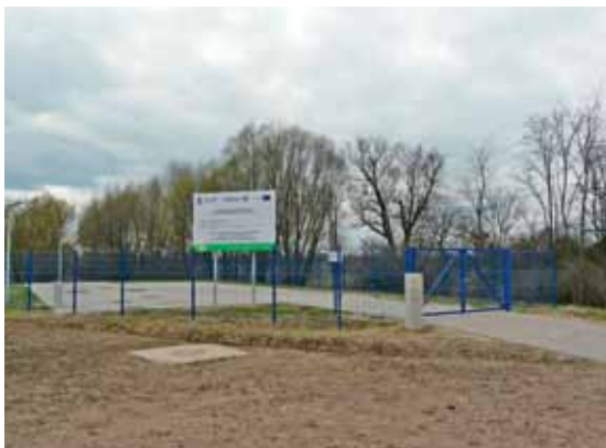
Podczyszczalnia wód deszczowych. Kontrakt K-8/WV pn. „Budowa podczyszczalni wód deszczowych K-II, K-III, K-V na wylotach do rzeki Wisły” (fot. Piotr Rabant)
