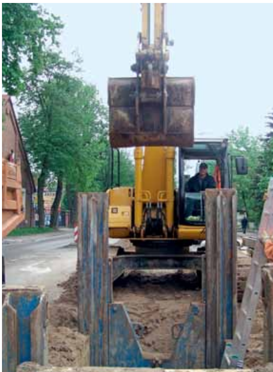
Budowa kanału deszczowego (fot. archiwum PWiK Elk)
