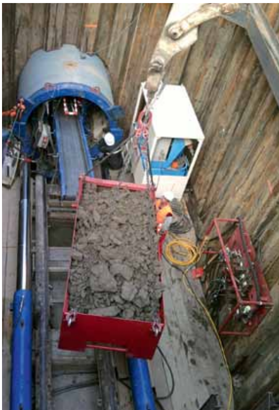
Budowa Kolektora Prawobrzeżnego II, 1
