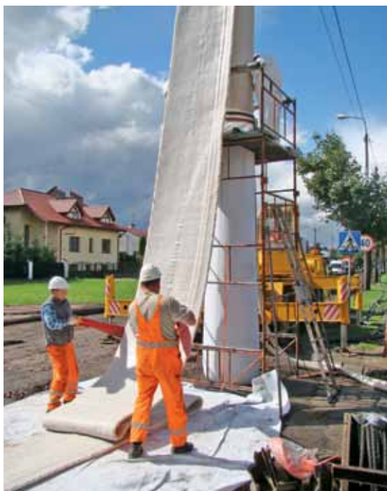
Przebudowa i rozbudowa kanalizacji w ul. Prusa I (fot. Archiwum PWIK)
