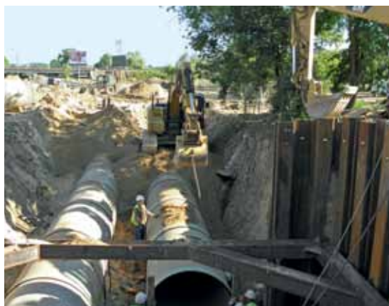
Budowa Kolektora Prawobrzeżnego II, 2
