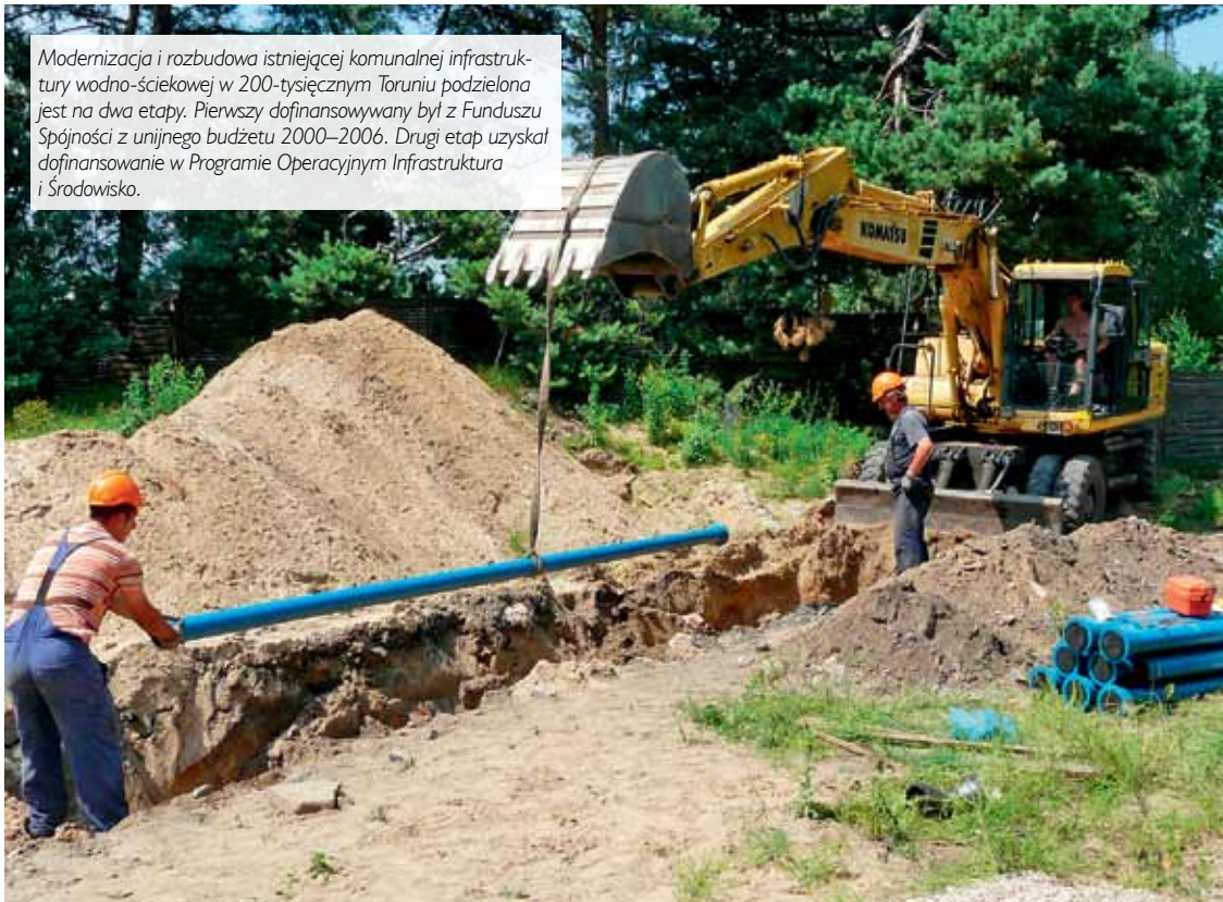
Budowa sieci wodociągowej na terenie osiedla mieszkaniowego Kaszczorek w Toruniu. Kontrakt K-4/W pn. „Budowa sieci wodociągowej i kanalizacji sanitarnej na terenie osiedla mieszkaniowego: Pancernych, Bielawy i Kaszczorek w Toruniu” (fot. Piotr Rabant)
