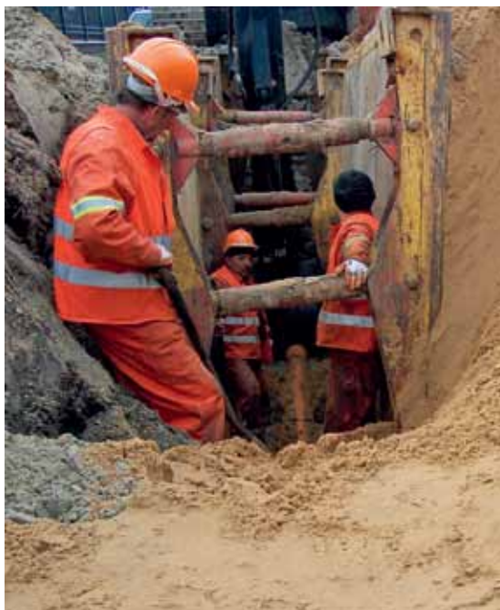
Kontrakt 2A – roboty montażowe przy układaniu kanalizacji
