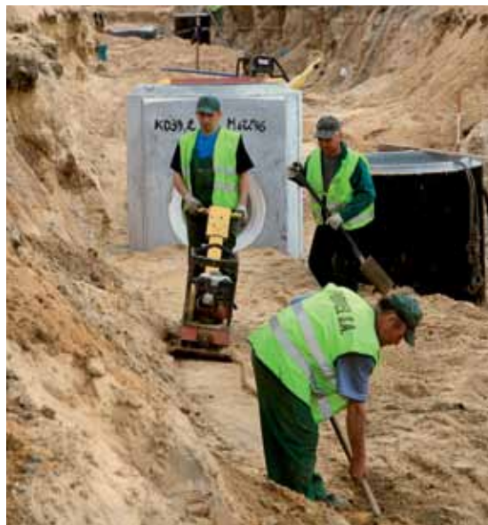
Prace na budowie kanalizacji w Bełchatowie (fot. Archiwum ZWIK „Wod-Kan” Bełchatów)
