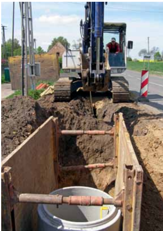
Budowa kanalizacji w Nadolniku (fot. Agnieszka Purczyńska)
