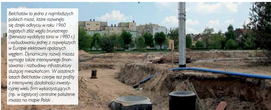
Prace na budowie kanalizacji w Belchatowie (fot. Archiwum ZWIK „Wod-Kan” Belchatów)
