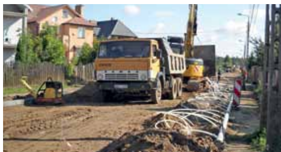
Roboty na osiedlu Dojlidy Górne (fot. Jarosław Parzyszek)
