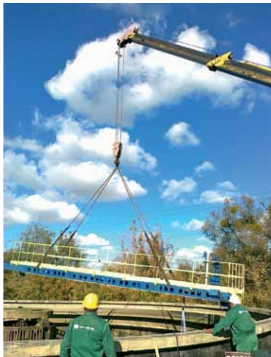
Oczyszczalnia – remont wyposażenia osadnika wtórnego – demontaż pomostu zgarniacza
