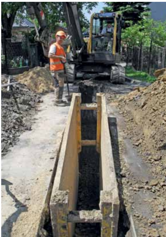
Budowa kanalizacji w dzielnicy Komorowice Krakowskie (fot. Archiwum „AQUA” S.A.)
