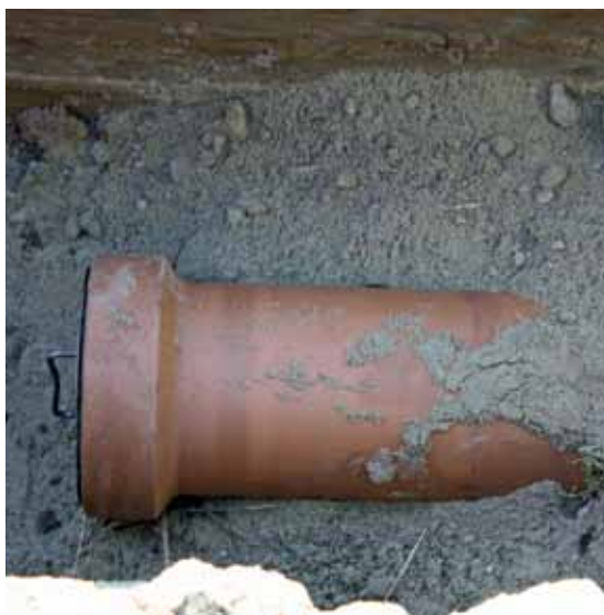
Rury kamionkowe – prawidłowe posadowienie w wykopie (fot. archiwum JRP)
