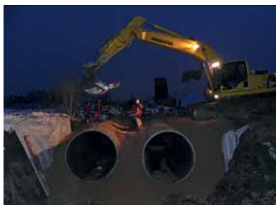
Budowa kolektorów zastępujących rów Strzala 3 (fot. Archiwum PWiK)
