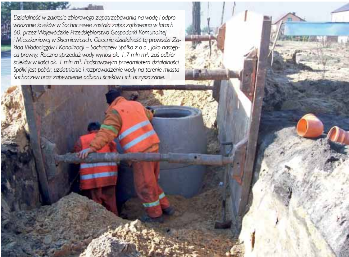
Kontrakt 2A – montaż studni na sieci kanalizacyjnej
