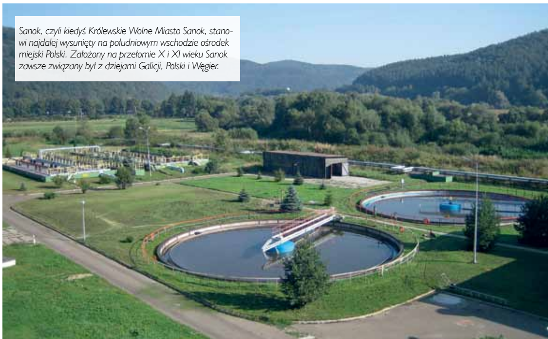
Oczyszczalnia ścieków w Trepczy (fot. Edyta Drwięga)
