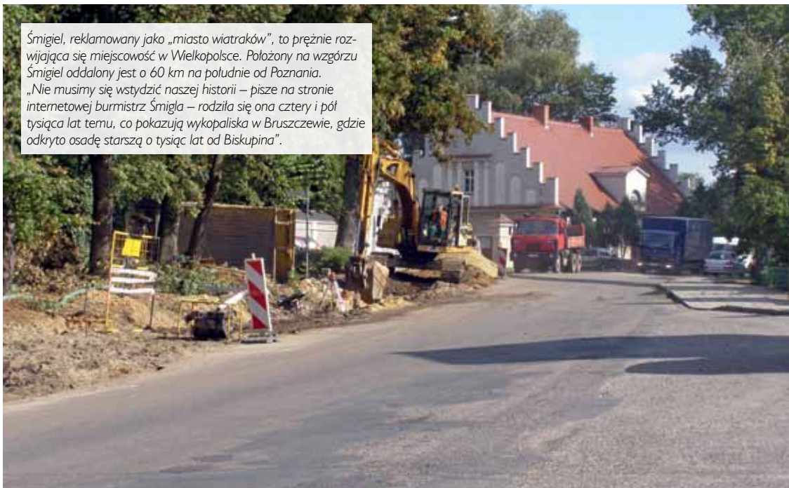
Budowa kanalizacji w Czaczu (fot. Agnieszka Purczyńska)
